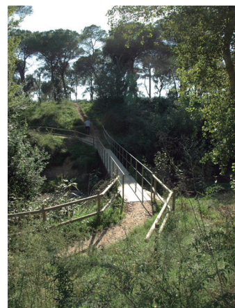
Passera de la Campinya. Imatge esquerra: durant la restauració. Imatge dreta: tardor 2014.
