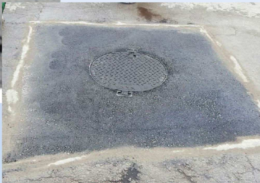
Foto 8: Pavimentació del tram afectat.
