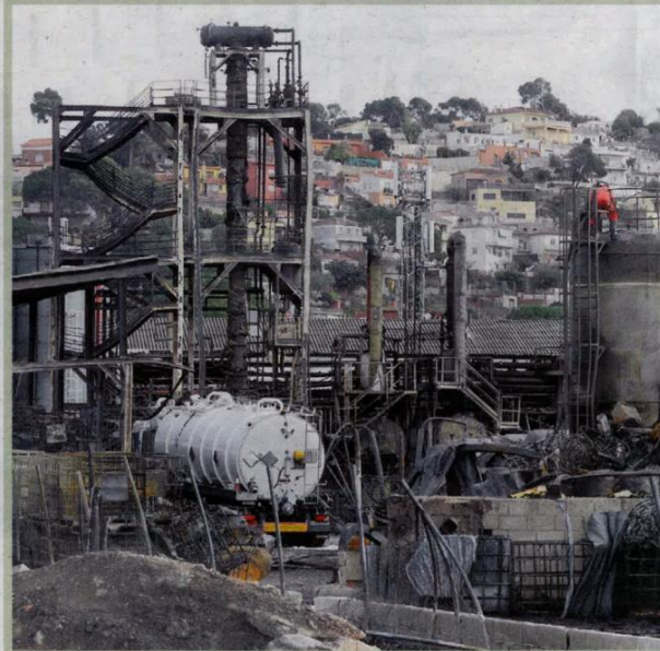
Les restes calcinades de la fàbrica, aquest dijous amb un camió cisterna
