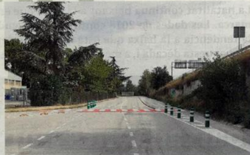
Un dels trams de carril bici segregat de la ruta de la Tourdera on es treballa
