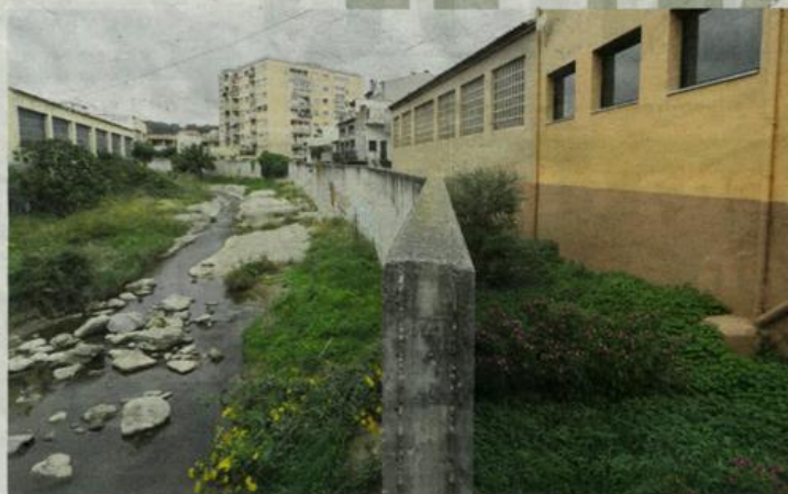
A l'esquerra, el mur de formigó que es va construir a Aiguafreda després de les inundacions de 1994 i que no va acabar-se. A la dreta, cartells a Santa Eulàlia sobre els plans d'evacuació en cas de rierada als barris propers
